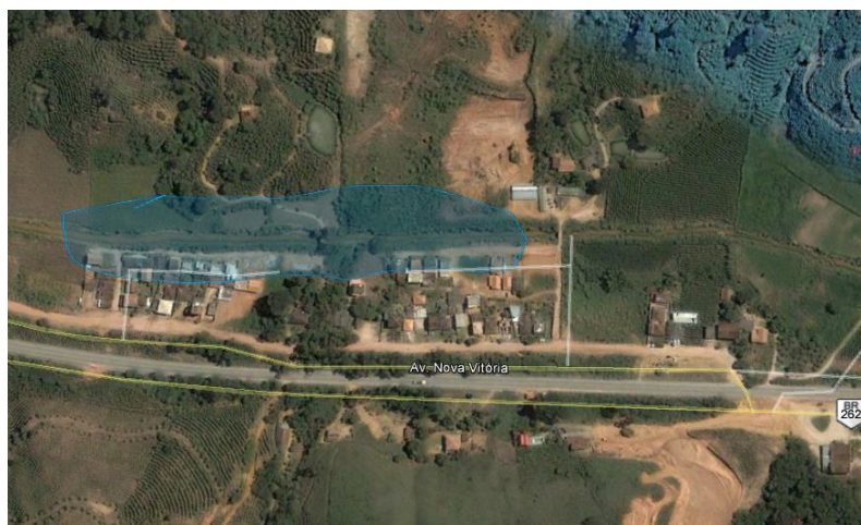
Figura 3-28 - Área sensível a inundação atrás da Av. Nona Vitória.
