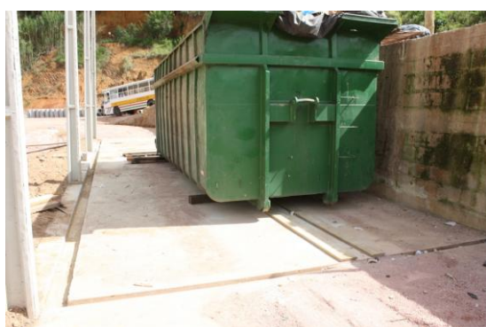
Figura 04 – Impermeabilização do piso e implantação de canteiros para coleta.
