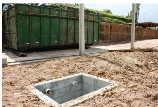
Figura 05 – Implantação de caixa coletora de chorume.
